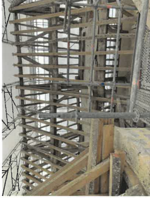
24. Charpente du château de Piffonds en cours de restauration
